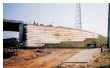
OSŁONA PRZYZCŁÓWKÓW Z BLOCzków PREFABRYKOWANYCH
