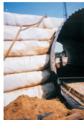
NASYP DROGOWY OD WSCHODNIEJ STRONY MOSTU
