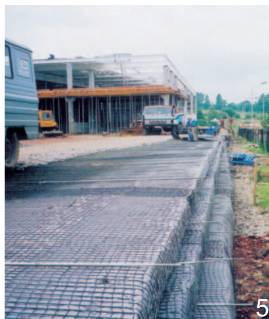
Uformowana kolejna warstwa stromego nasypu
