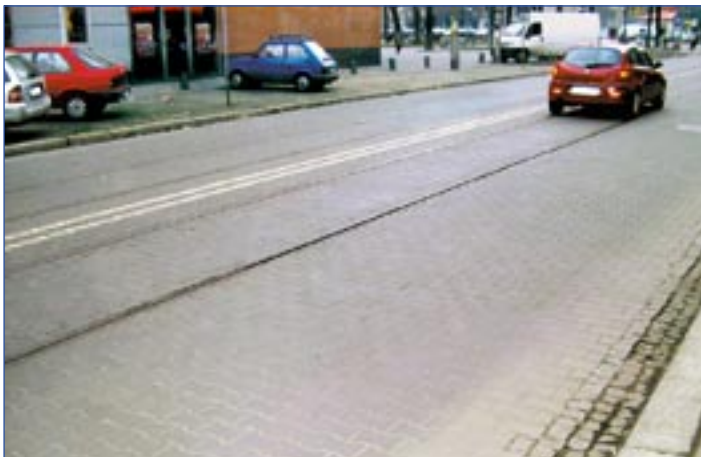
Fot. 8 i 9. Ulica Gliwicka w Katowicach. Zdjęcie pierwsze przedstawia odcinek wykonany na kwalifikowanych GPwRW. Drugie zdjęcie przedstawia natomiast inny odcinek tej samej ulicy wykonany rok później – zamieniono na nim materiały kwalifikowane na niekwalifikowane. Różnice i skutki zamiany widoczne na zdjęciach powyżej (fotografie wykonano 18.03.2004 r.).
