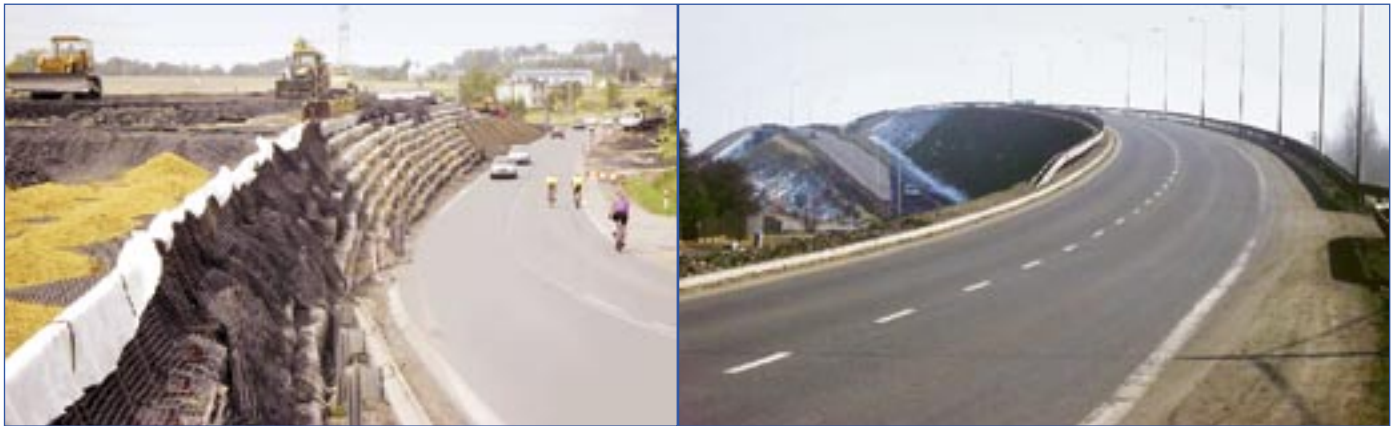
Fot. 1 i 2. Najazdy do wiaduktu w ciągu DW-933 w Jastrzębiu-Zdroju. Nasypy budowane na granicy IV i V kategorii aktywności górniczej. Długość nasypów: 750 m, wysokość: maks. 20 m. Zastosowano kwalifikowane GPwRW.
