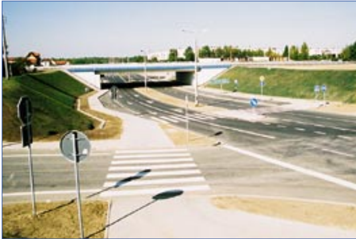
Fot. 6. Skrzyżowanie DK-1 z ul. Sikorskiego w Tychach. Jezdnie o długości po około 100 m każda zostały zawieszono nad upłynnionymi filami. Zastosowano kwalifikowane GPwRW.
