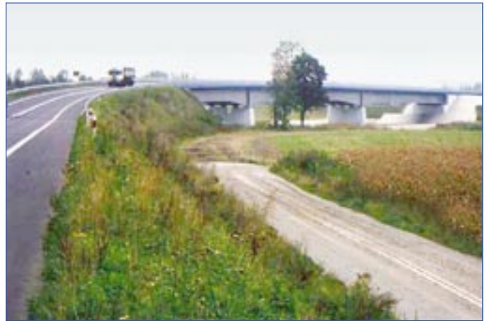
Fot. 3. DK-78. Najazdy do mostu nad rzeką Odrą w miejscowości Olza. Łączna długość nasypów: 1440 m, wysokość: maks. 16,5 m. Zastosowano kwalifikowane GPwRW.
