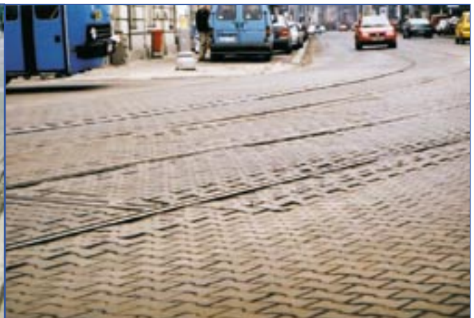
Fot. 8 i 9. Ulica Gliwicka w Katowicach. Zdjęcie pierwsze przedstawia odcinek wykonany na kwalifikowanych GPwRW. Drugie zdjęcie przedstawia natomiast inny odcinek tej samej ulicy wykonany rok później – zamieniono na nim materiały kwalifikowane na niekwalifikowane. Różnice i skutki zamiany widoczne na zdjęciach powyżej (fotografie wykonano 18.03.2004 r.).
