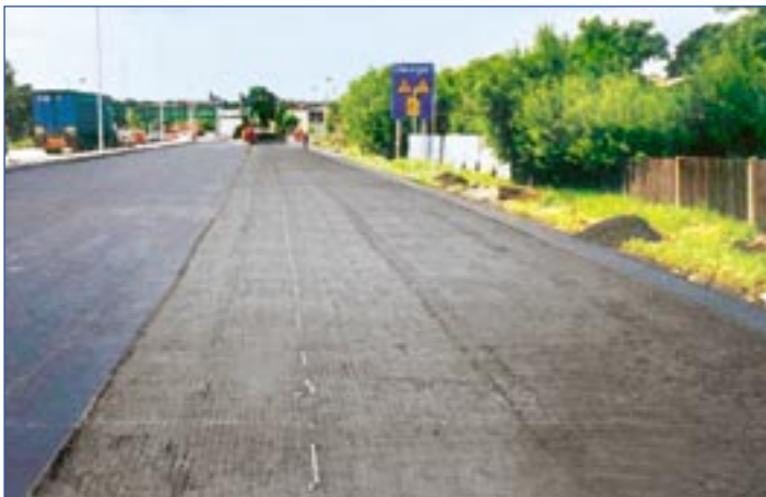
Fot. 7. Rehabilitacja i wzmocnienie nawierzchni w ciągu DK-81. Zastosowano kwalifikowaną siatkę z PES na „podszewkę” z PP, nasączoną w procesie produkcji bitumem. Inwestycję zrealizowano dotychczas na odcinku od Mikołowa do Zor i od Zor do Zbytkowa.
