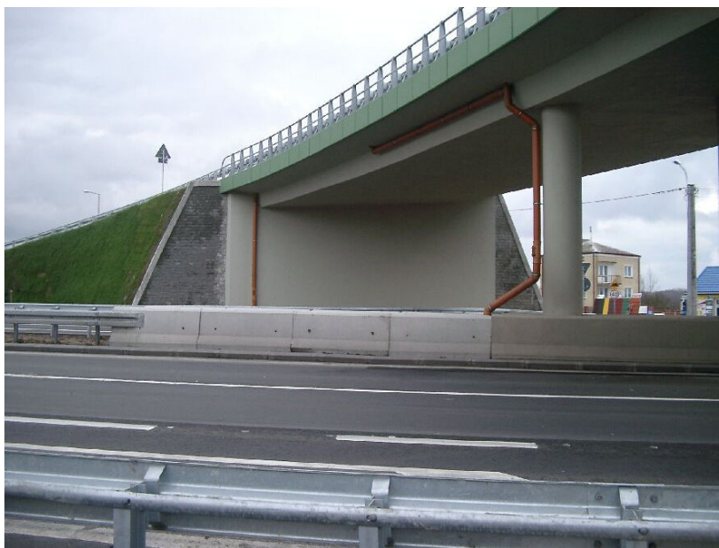
Fot.4 Skrzydła przyczółków mostowych z pionowo ułożonych, prefabrykowanych bloczków betonowych systemu LEROMUR ® kotwionych geosiatką FORNIT ® .
